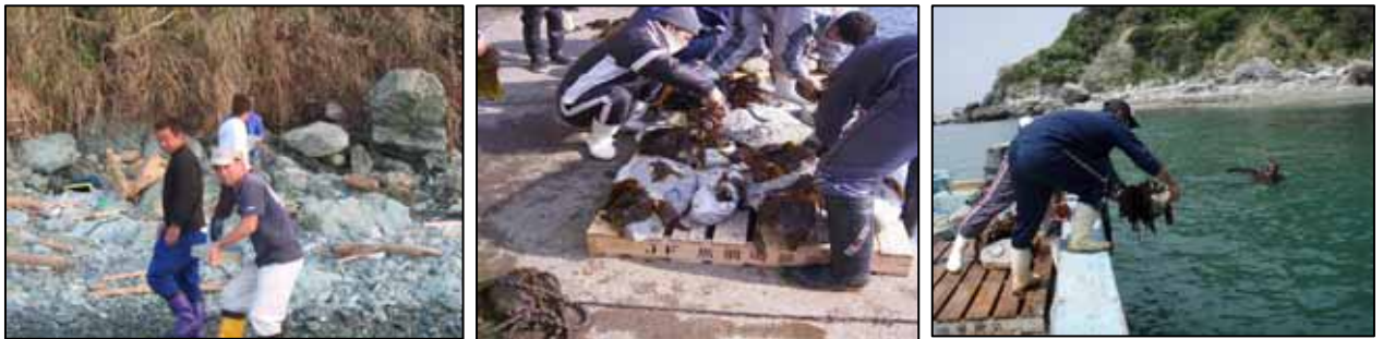
写真2 海岸で集めた石にモルタルで針金を埋め込み、アラメ幼体を取り付けて海底に投入
